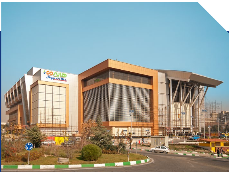
Mega Mall بازار بزرگ اکباتان (مگامال) کارفرما: شرکت آرمه نو محل پروژه: تهران، بزرگراه شهید ستاری ارتفاع ساختمان: ۳۰ متر سیستم اجرا شده: AW3S نوع سیستم: Semi Unitized متراژ نما: ۴۰۰۰ مترمربع
